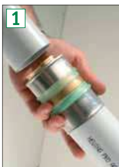
1 Osadzenie rury w złączce.
